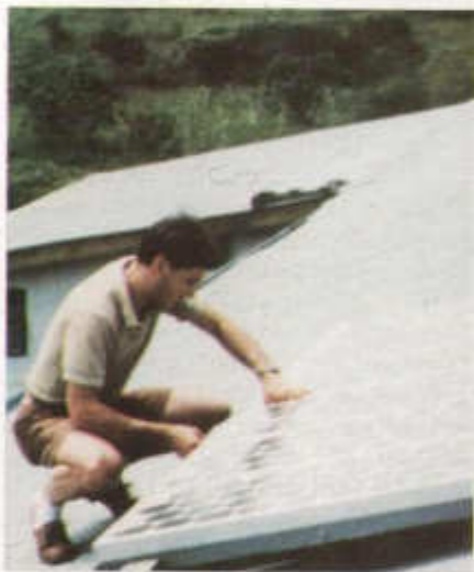
Flavio Purgato mentre ripara l'impianto fotovoltaico della missione di Warr (Uganda).
